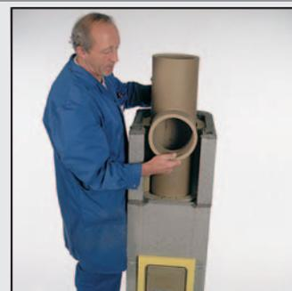
20 Установите внутрь тройник для подключения потребителя. Выступ на верхней грани керамической трубы должен всегда находиться снаружи, канавка внутри. Ориентация т.н. «по воде» действует для всех видов топлива.
