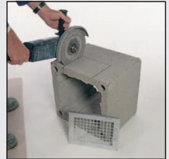
4 При помощи угловой шлифовальной машины вырежьте в следующем блоке отверстие для вентиляционной решётки.
