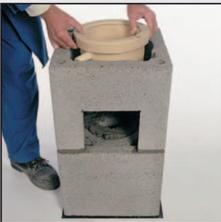
5 Блок установите на раствор на подготовленном цоколе. Выровняйте при помощи уровня. Для удобства эксплуатации размещайте отверстие для подачи воздуха, а также дверцы для очистки дымохода под углом 90° к оси подключаемого потребителя. Установите ёмкость для сбора и отвода конденсата в центре блока на цементный раствор.
