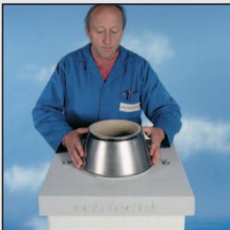
49 Наденьте конус на распорное кольцо. Используйте его как средство измерения для определения высоты верхнего керамического элемента. Обрежьте трубу до требуемого размера и установите.
