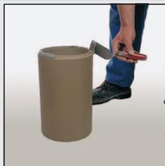
27 Нанесите смесь для заделки швов на нижнюю грань внутренней керамической трубы.
