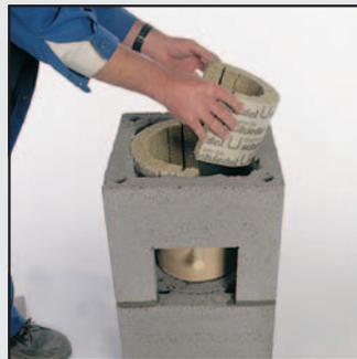
7 Следите за тем, чтобы изоляционный материал не засорил каналы вентиляции дымохода. Трубопровод для отвода конденсата выведете в отверстие вентиляционной решётки, а затем подключите к системе канализации.
