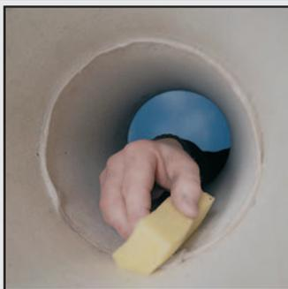
21 После установки тройника удалите влажной губкой излишки массы для заделки швов, а швы внутри выровняйте так, чтобы внутренние стенки были гладкими, а шов полностью заполнен.
