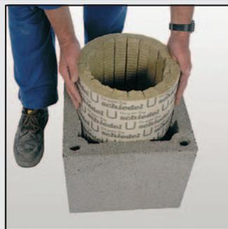
23 Вставьте два изоляционных элемента внутрь каменной оболочки.
