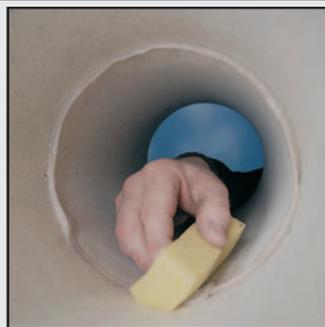
15 Избыточную массу для заделки швов после установки керамических элементов всегда удаляйте влажной губкой, а швы внутри ровняйте так, чтобы внутренние стенки были гладкими, а шов полностью заполнен.
