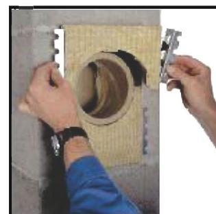
1. Для правильного выбора размера «А», измерьте внешний диаметр подсоединяемого элемента тройника.
